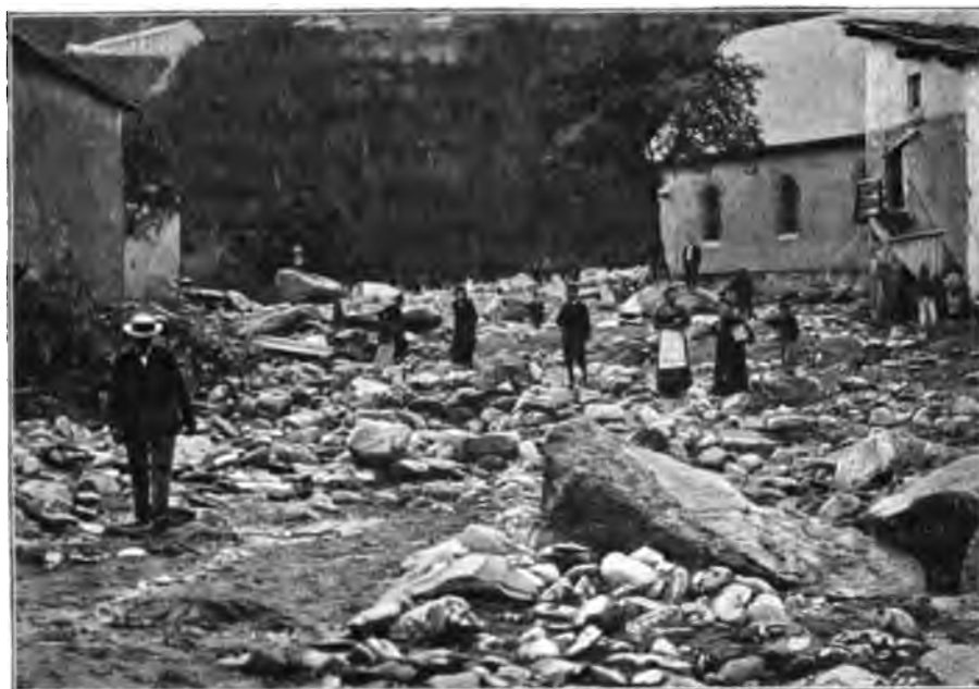
FIG. 6. — PARTIE DU VILLAGE DES FOURNEAUX, DANS LE VOISINAGE DE L'ÉGLISE. LA « LAVE » ET LES BLOCS RECOUVRENT DES JARDINS. C'EST LÀ QUE LE TORRENT S'EST DIVISÉ EN DEUX BRAS. Reproduction d'une photographie de M. Montaz, photographe à Modane.
